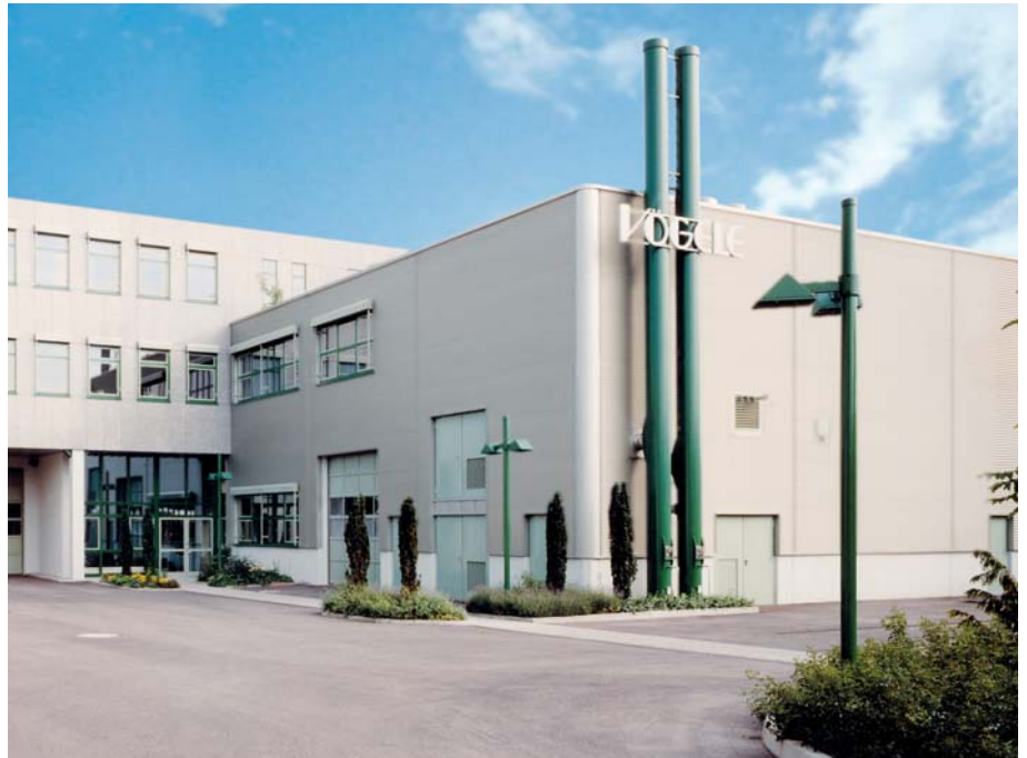
Verwaltungs- und Fabrikationsgebäude Aromen
